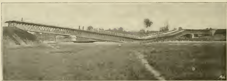
Abb. 10. Eisenbahnbrücke über die Weichsel [Strecke Oswiecim-Myslowitz] nach der am 23. Juni 1866 erfolgten Sprengung.
